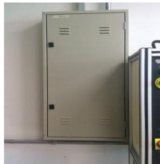
Figura 3 – Imagem retirada do laboratório de Máquinas e Acionamentos do IFTM – campus Patos de Minas, representando o quadro de distribuição e a falta de sinalização no mesmo.
